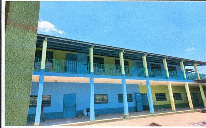
Foto 1: Avance de la pintura en las instalaciones del establecimiento.
