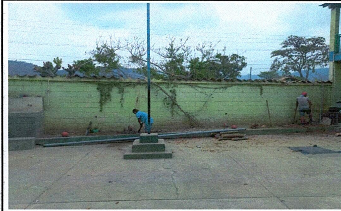
Foto 1: Se quitaron las palmeras para poder empezar los trabajos del muro perimetral.
