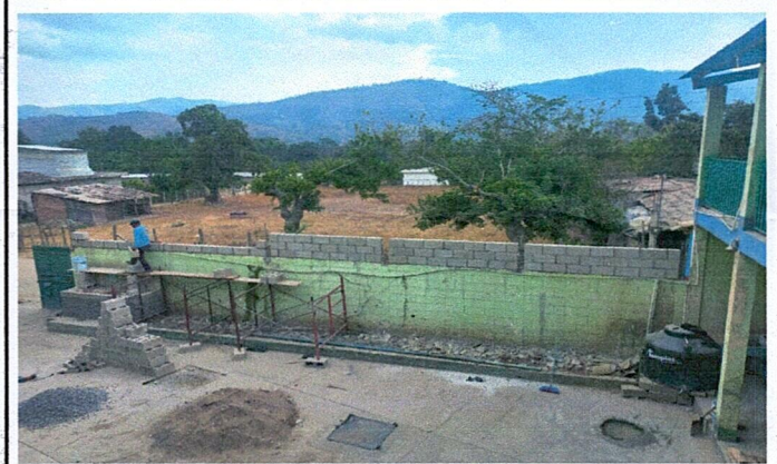
Foto 4: Avance de la colocación de block en el muro..
