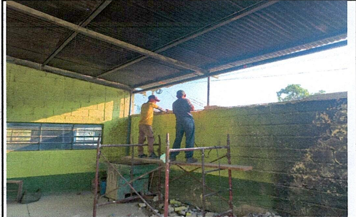
Foto 2: Se quita la pestaña de concreto, para poder pegar el block.
